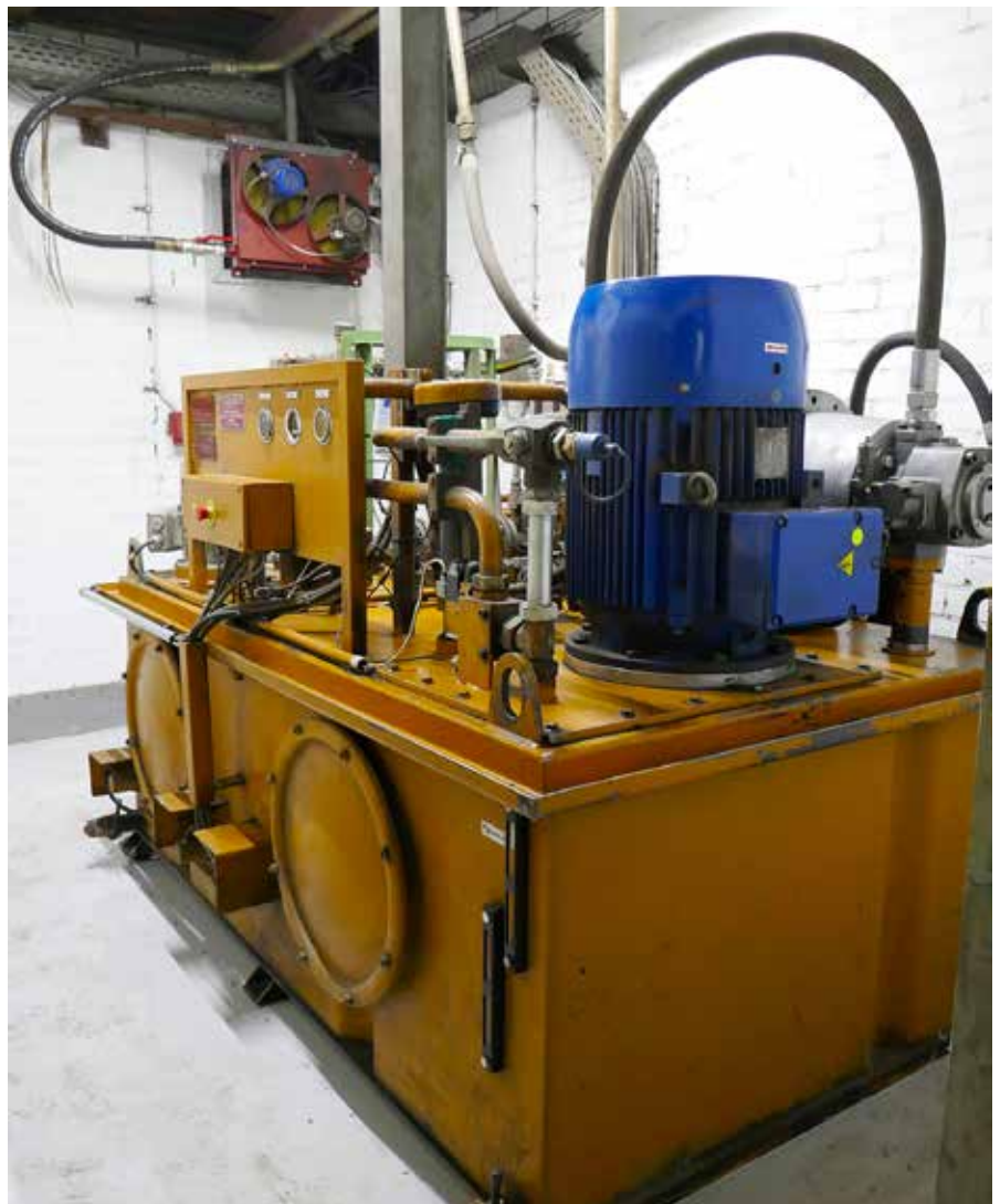
De drie hydraulische installaties in de vormlijn zijn aangesloten op een centraal hydraulisch aggregaat.
